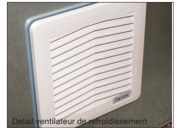
Détail ventilateur de refroidissement
