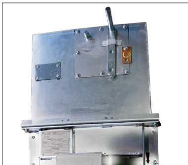
Fusible de rechange et levier d'armement
