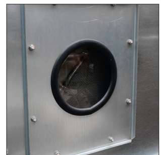
Inspectie luik Geïntegreerd inspectie luik voor toezicht op functionering.
